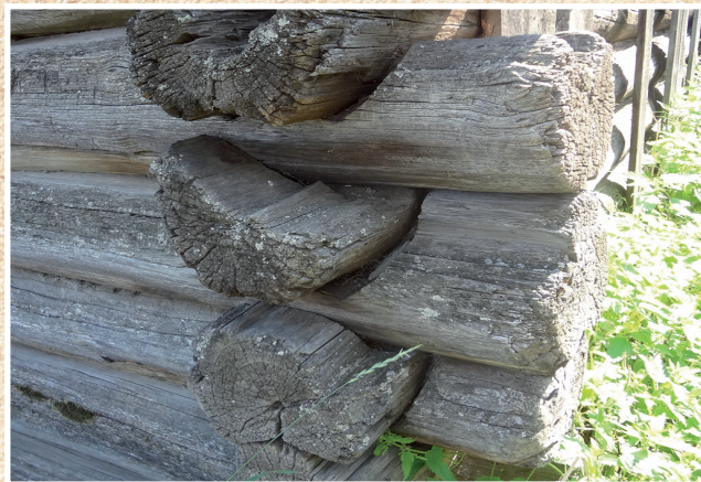
п. Подъяеланка. Угол дома. Рубка в обло или чашу
